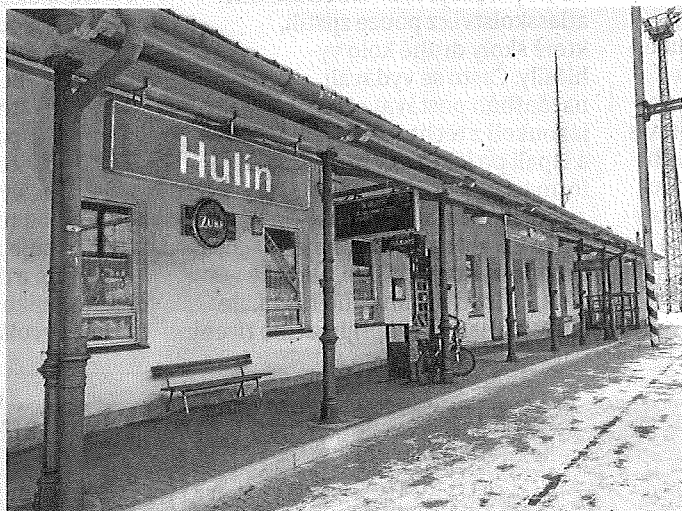
ŽELEZNIČNÍ STANICE v Hulíně v prosinci 2022.
