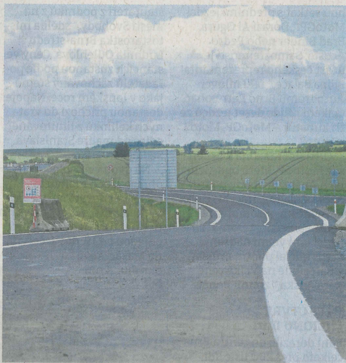
PŘED OTEVŘENÍM. Úsek dálnice od Hulína po Fryšták je dokončený, řidičům se otevře v sobotu 20. června. Foto: Deník/P. Procházková
