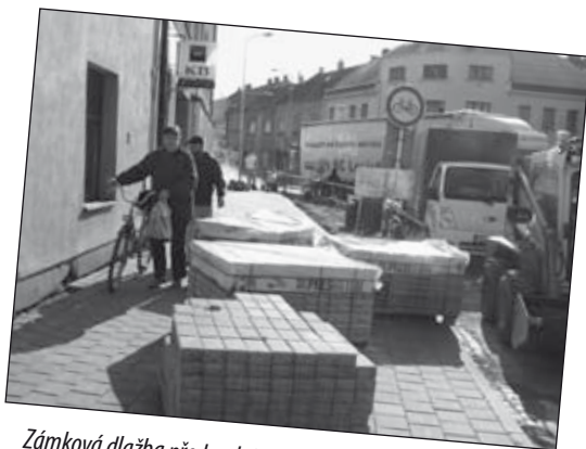
Zámková dlažba před radnicí je jen jednou z opravených částí chodníků vedoucích až k Myší díře.
