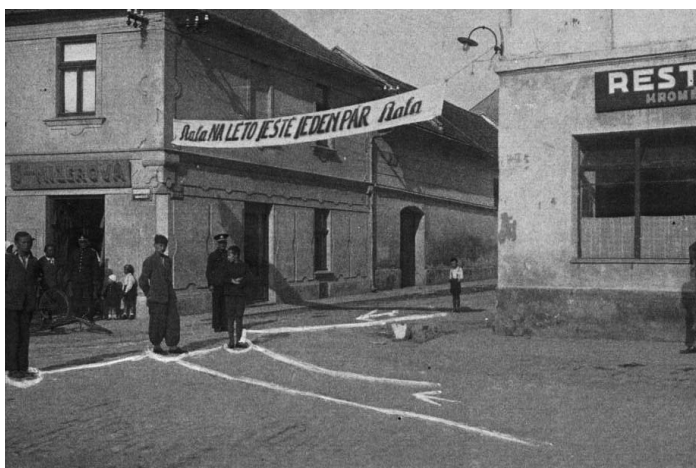
Náměstí bylo vždy vhodným místem pro reklamu. Věděla to i firma Baťa
