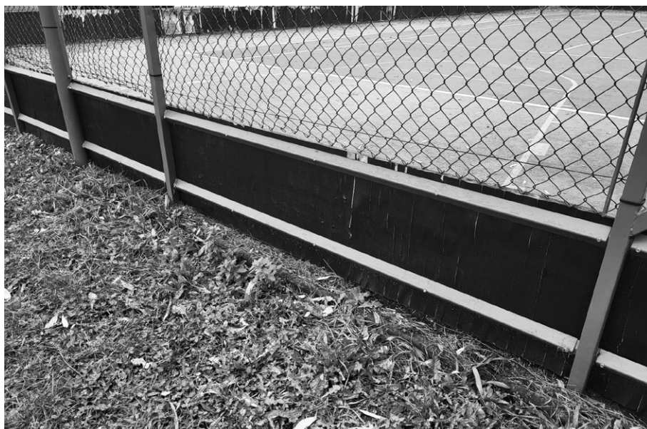
Spodní část oplocení multifunkčního hřiště bude vyměněna za plastové desky.
