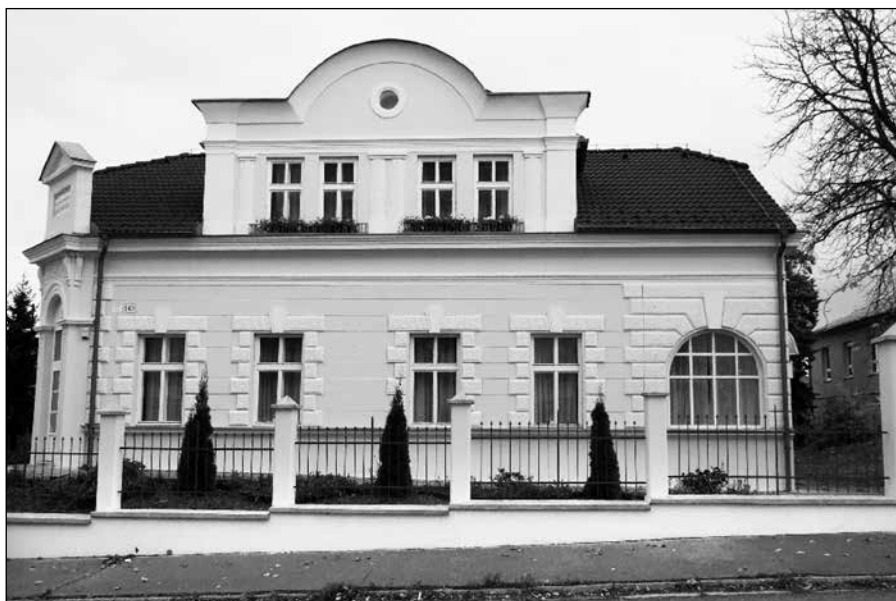
Opravený dům Josefa Zavadila v Děvínské Nové Vsi.
