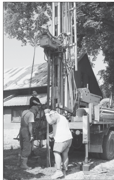
Vrtání studny v Záhlinicích skončilo neúspěšně.
