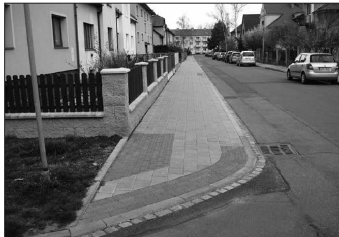
Chodník na ulici Wolkerova v Hulíně.
