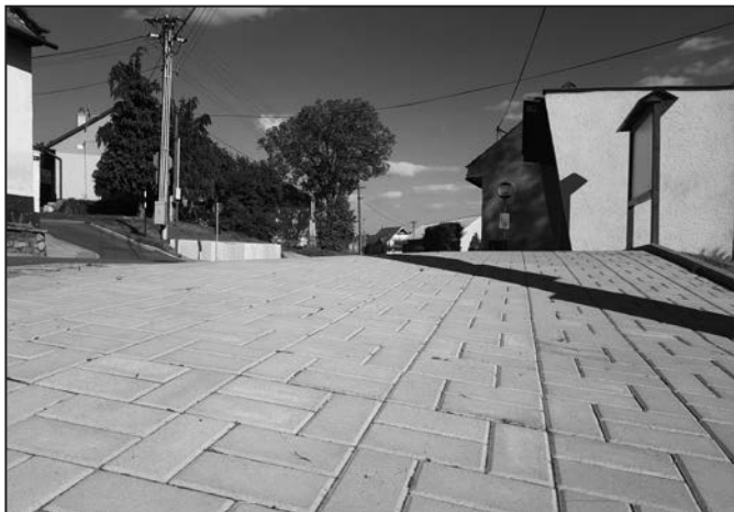
Chodník, zastávky a veřejné osvětlení v obci Sulimov.
