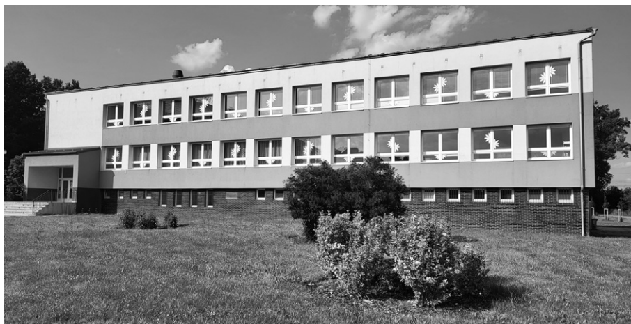
V základní škole bude SATE Hulín instalovat fotovoltaickou elektrárnu. Foto: MÚ Hulín
