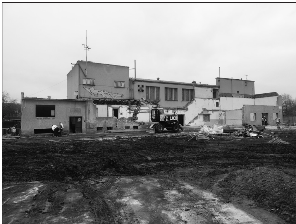
Sokolovna se proměnila ve staveniště
