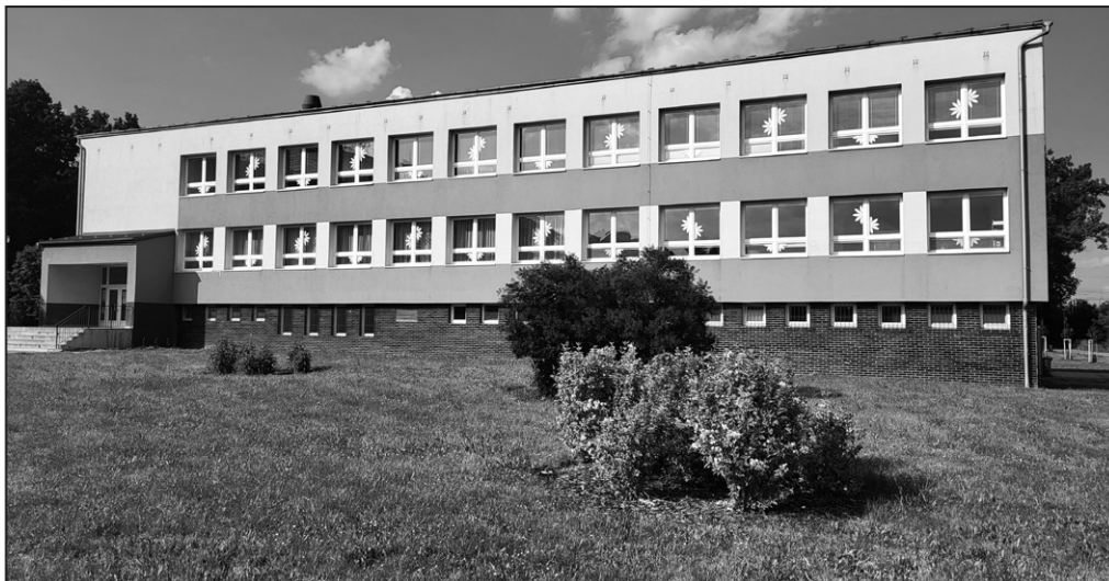
V pavilonu jídelny ZŠ se bude opravovat vzduchotechnika. Foto: J. Žůrek
