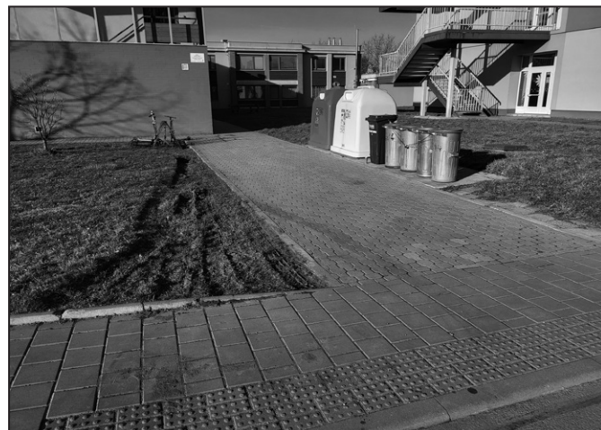
U DPS Nábřeží dojde k rozšíření a podbetonování chodníku
