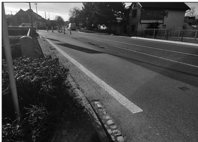
Pokračuje oprava poslední třetiny mostu přes Rusavu
